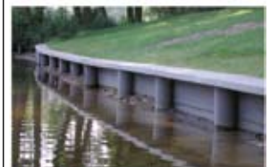
TRIMAX als Uferbefestigung
